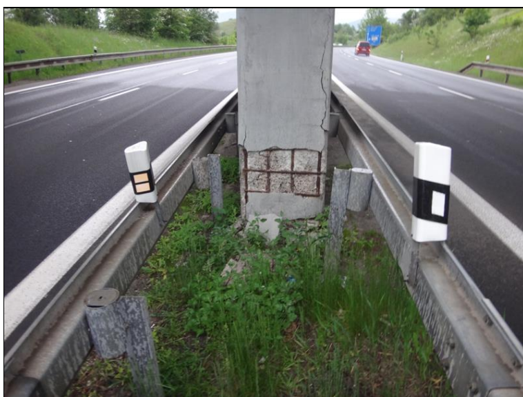
Poruchy ve sloupech pilířů
