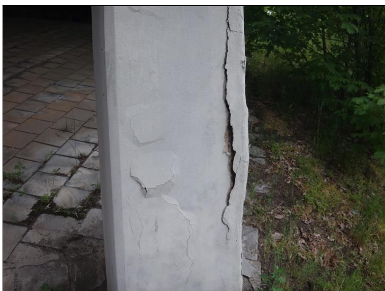
Poruchy ve sloupech pilířů
