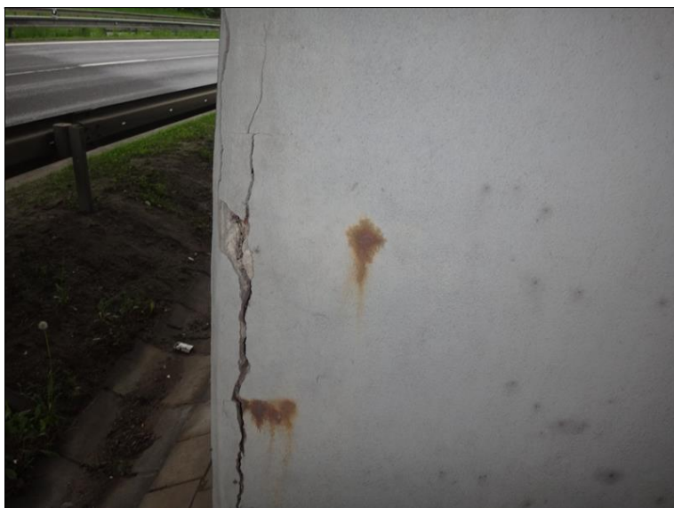
Poruchy ve sloupech pilířů
