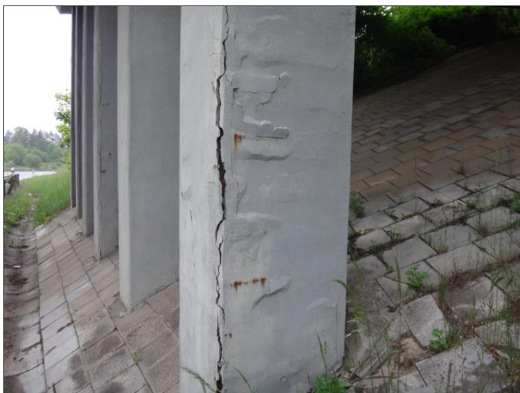
Poruchy ve sloupech pilířů
