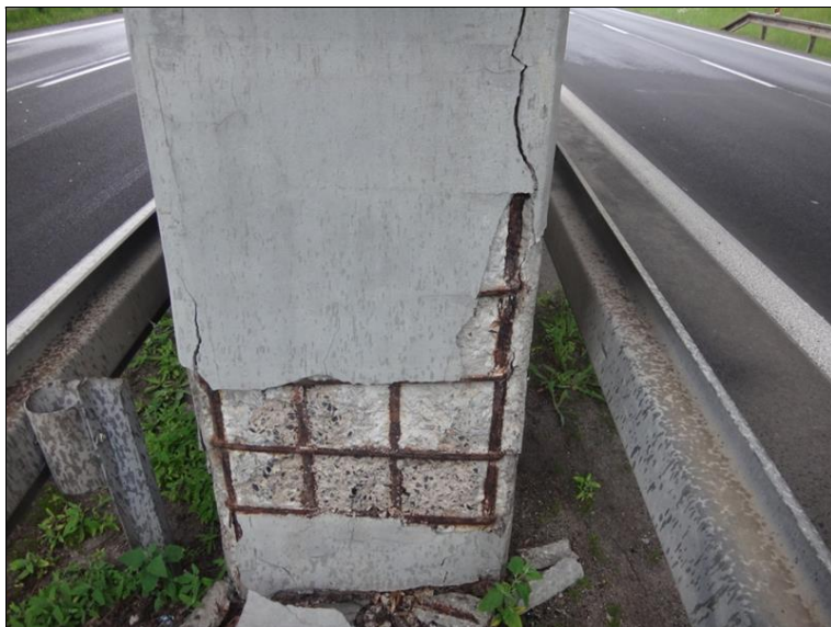
Poruchy ve sloupech piliřů
